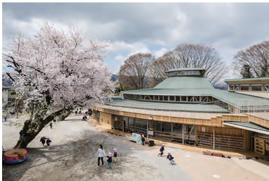
写真1 園庭からの外観
