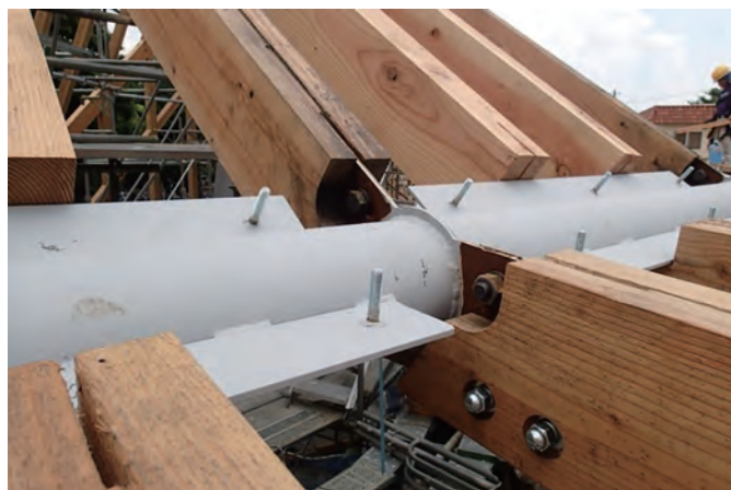
写真4 吊り梁接合部
