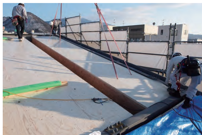
写真7 LVLパネル部材の設置
