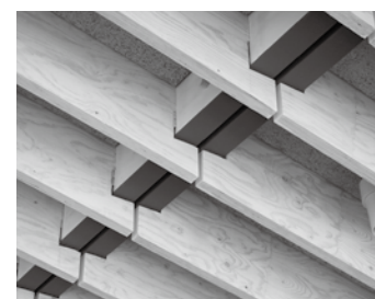
⑥LVLパネルと鉄骨梁
