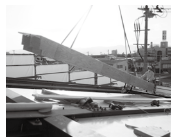
③LVLパネル建方
