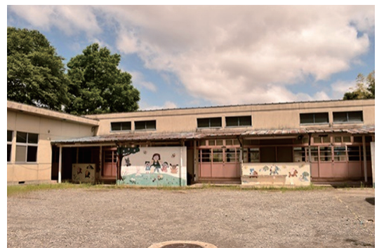
写真2 旧園舎 (改修前) (Photo: みしま未来研究所)
