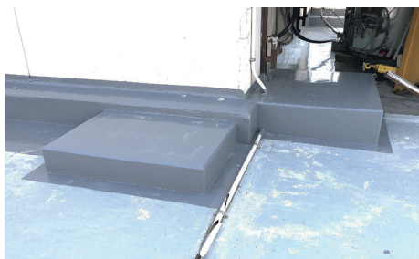
鉄骨梁接合部補強 (RCとの接続部)
