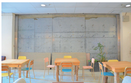
商業施設内(低層階)の増打ち補強壁
