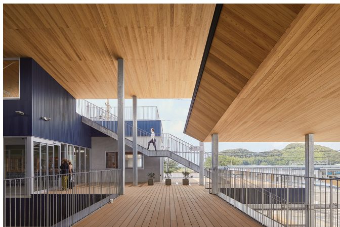
木造のサイズ感の柱と木質化した軒裏（撮影：楠瀬友将）
