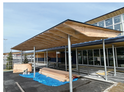
身障者用駐車場の木垂木（建方時）
